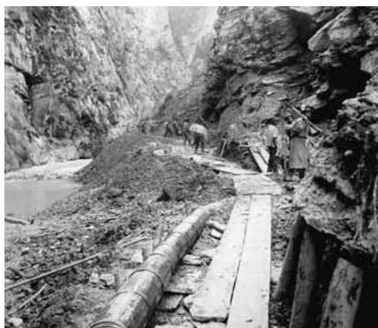
Bau der Teuchelleitung vom Bad Pfäfers zum Hof Ragaz
