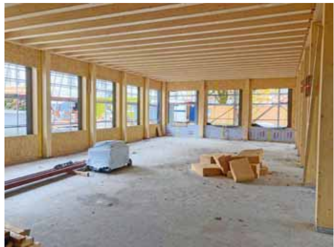
Abbildung 13: Schulhausneubau Sarganserstrasse 6a; Rohbau Aula-Mittagstisch
