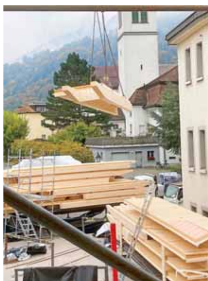
Abbildung 15: Schulhausneubau Sarganserstrasse 6a; Montage Dachholzfertigelemente
