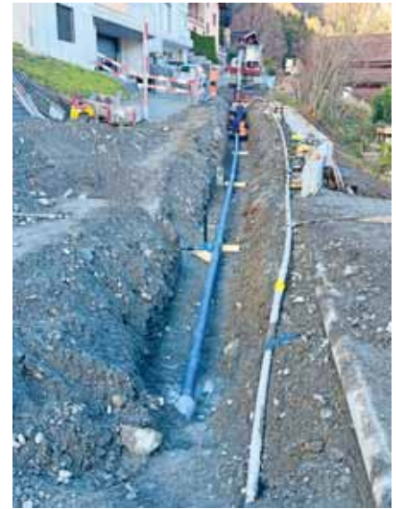
Abbildung 19: Obere Bidemsstrasse, Wasserleitung
