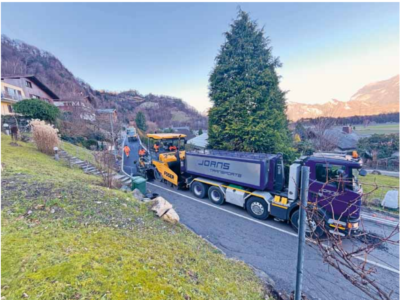
Abbildung 20: Obere Bidemsstrasse, Belagseinbau
