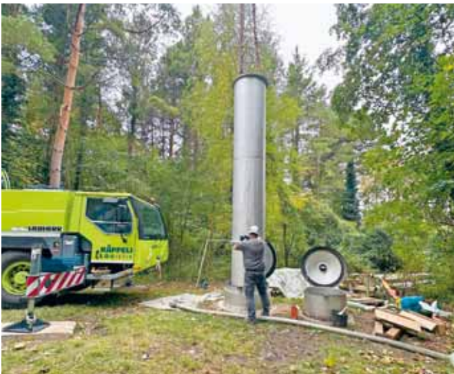
Abbildung 28: Einstellung der Edelstahl-Einschubverrohrung
