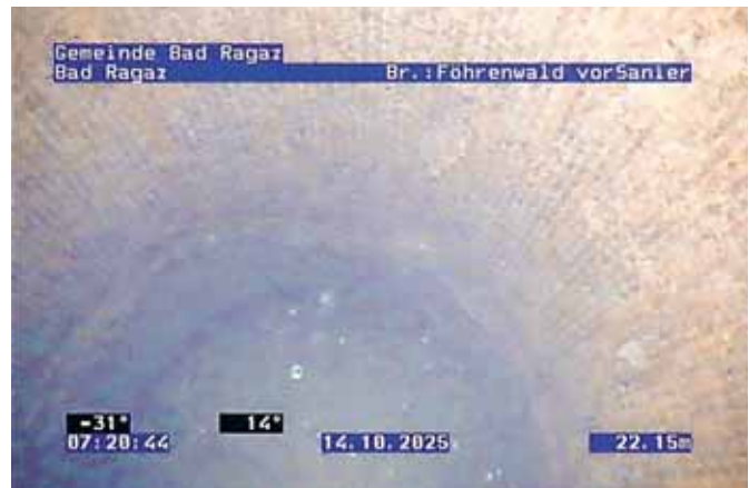
Abbildung 26: Ansicht auf den Brunnenboden mit den Ablagerungen
