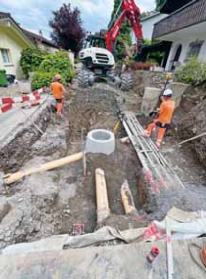
Abbildung 21: Obere Bidemsstrasse, Werkleitungsbau
