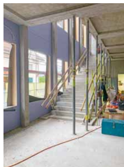
Abbildung 16: Schulhaus Sarganserstrasse 6a; Rohbau Treppenhaus in Stahlbeton
