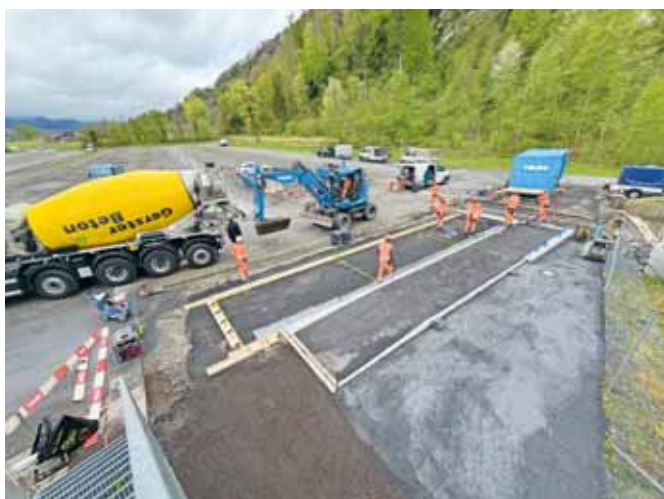
Abbildung 8: Bushaltestelle Matells, Betonarbeiten
