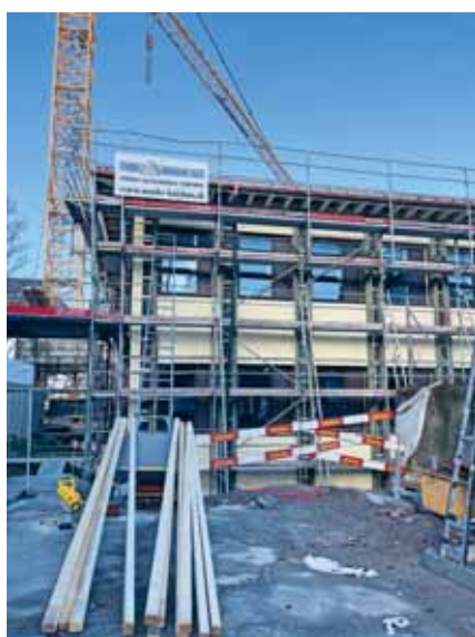
Abbildung 14: Schulhausneubau Sarganserstrasse 6a; Erstellung Holzfassade
