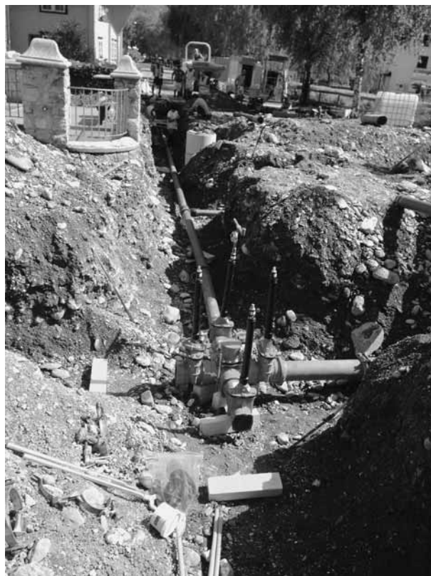
Ein neues Schieberkreuz wird an der Maienfelderstrasse beim Abzweiger in die Fläscherstrasse gesetzt.
