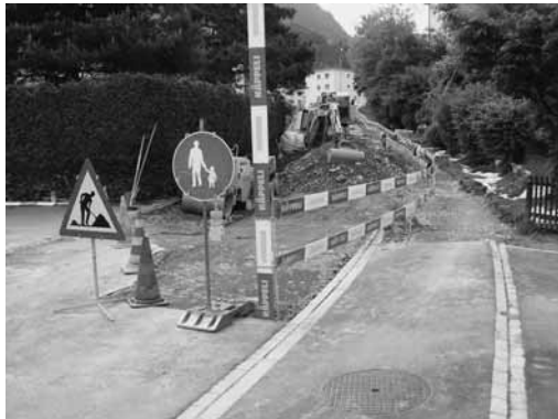
Das bestehende Trottoir an der Falknisstrasse wurde ab der Alvierstrasse bis zur Pizolstrasse weitergeführt.
