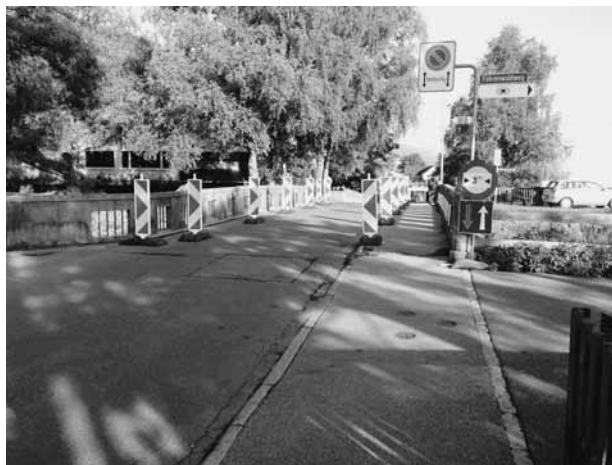
Blickrichtung Fläscherstrasse: Sandbrücke mit eingengter Fahrbahn zur Entlastung der Aussenträger.
