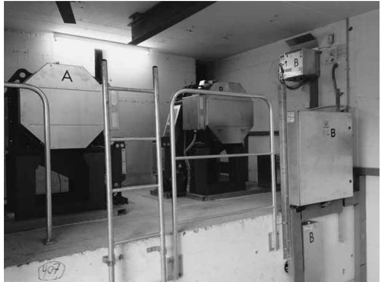
Neue Liftantriebe und Steuerungen
