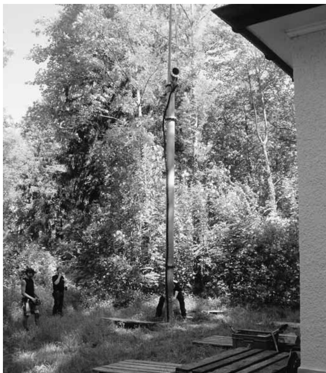
Die defekte Unterwassermotorpumpe mit Rohranlage und Stromkabel wurde mit einem Kran aus dem 22 m tiefen Grundwasserschacht gezogen.
