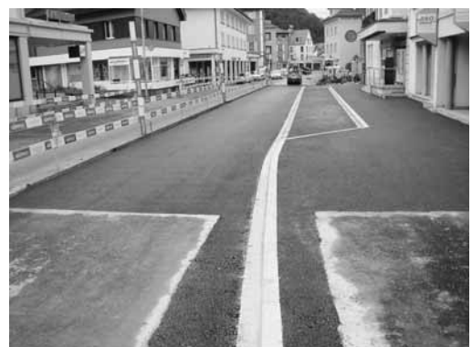
Entlang der Maienfelderstrasse konnten die Parkfelder der Blauen Zone in geschützte Buchten verlegt werden. Die Sichtzonen wurden optimiert.
