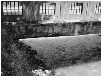
Träger auf der linken Brückenseite.
