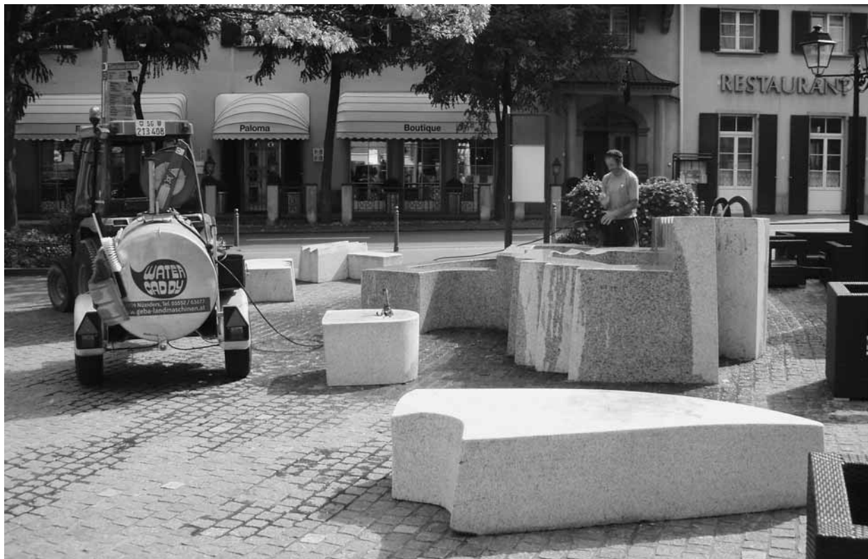
Reinigungsarbeiten bei einem Brunnen im Dorfzentrum.
