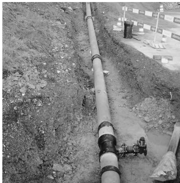
Die neu erstellte Druckleitung DN 250 ab der Pfäferserstrasse in Blickrichtung Valur. Die Entleerung am Tiefpunkt wurde an die bestehende Strassenentwässerung angeschlossen.
