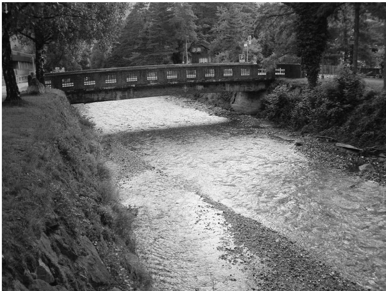
Blickrichtung Rhein: Sohlenlage der Tamina unmittelbar bei der Sandbrücke.
