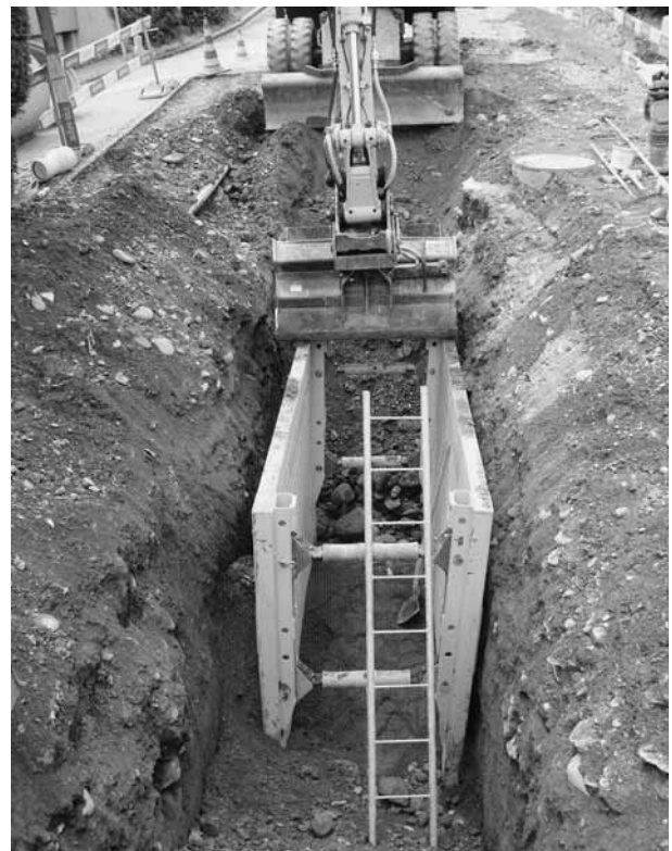
Für die tiefliegende Mischwasserkanalisation an der Falknisstrasse musste der Graben gesichert werden.
