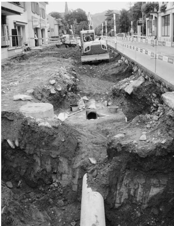
An der Maiefelderstrasse wurde die neue Meteorleitung für die Strassenentwässerung erstellt.
