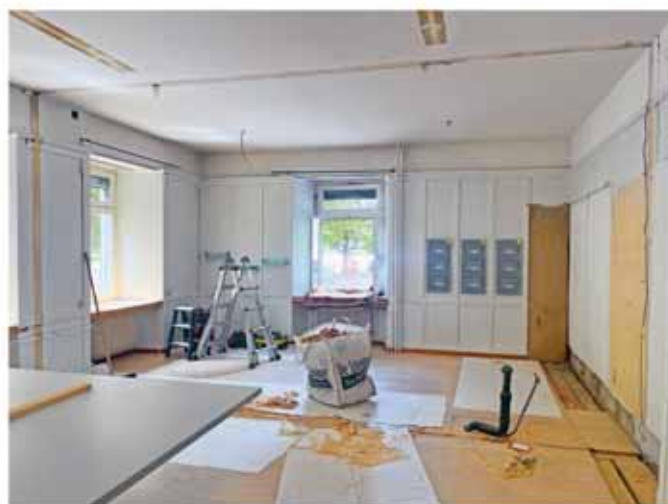
Umbau Lehrerzimmer Schulhaus Sarganserstrasse
