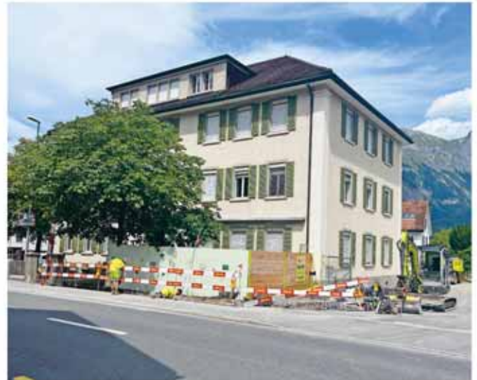
Neue Mauer Einmündung Wiesenweg in Sarganserstrasse
