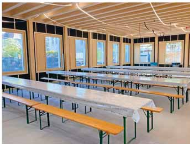
Blick in den Raum des künftigen Mittagstisches/ der Aula im Erdgeschoss des Schulhausneubaus, gestuhlt für den Aufrichtanlass der Handwerker am 24. April 2026
