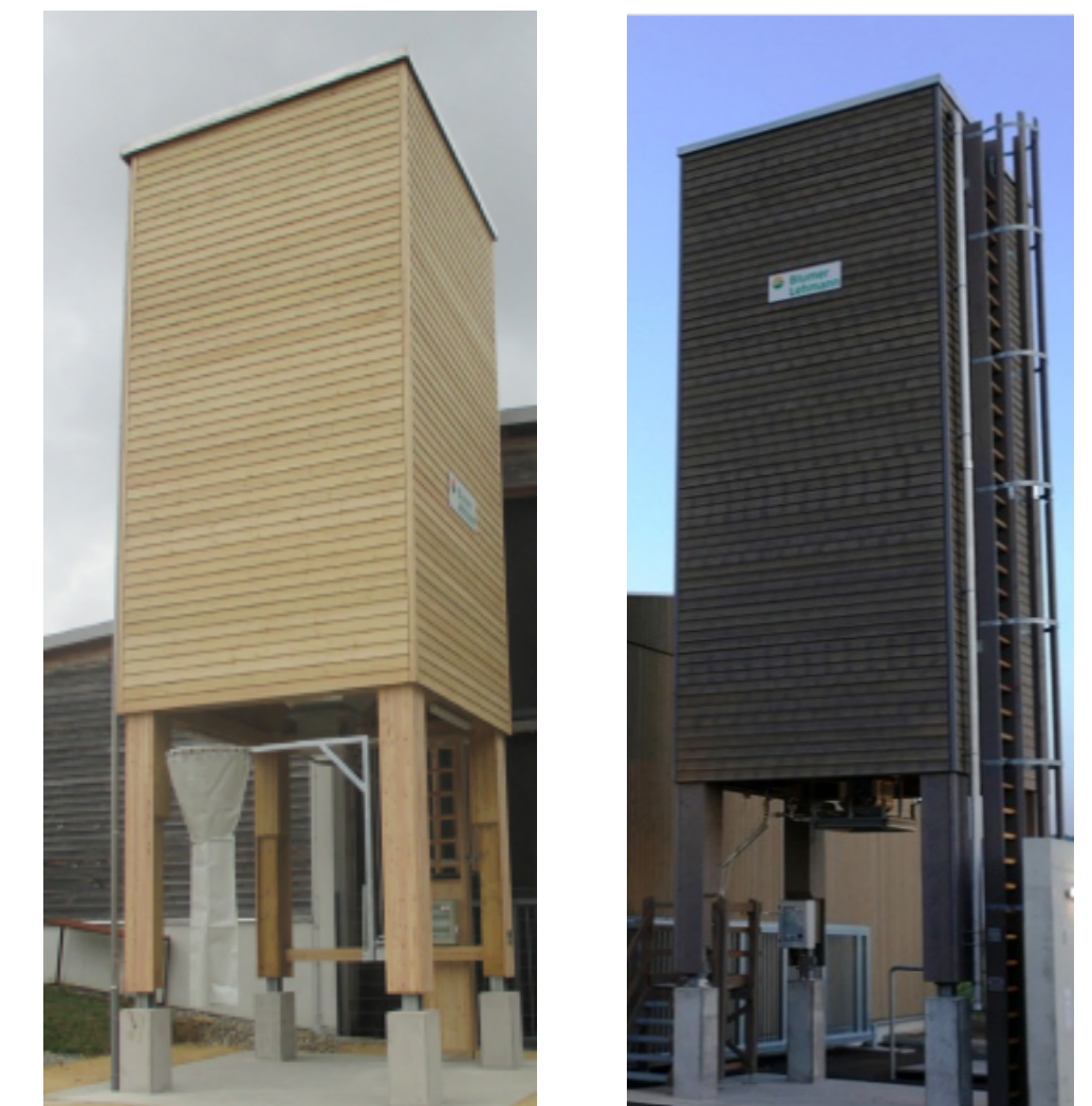
Salzsilo 50m³ Fassade gestaltet
