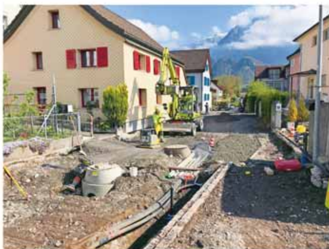
Werkleitungsbau im Bereich der unteren Kirchgasse
