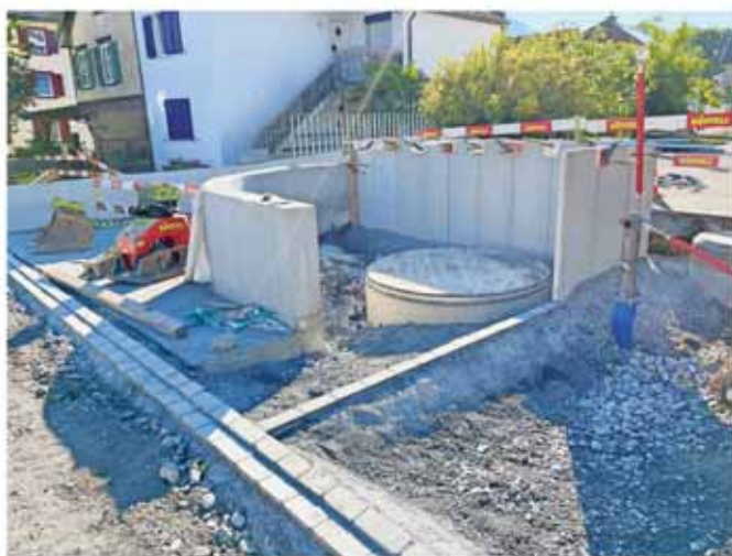
Errichtung Unterflurcontainer
