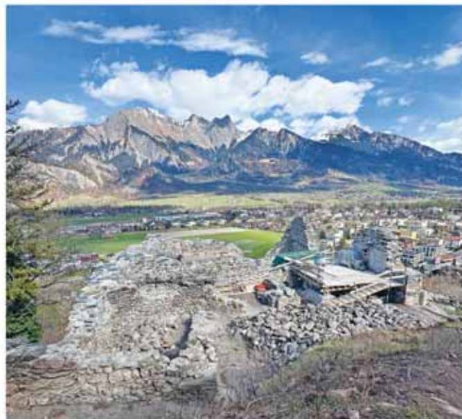
Die Sanierungsarbeiten schreiten voran.
