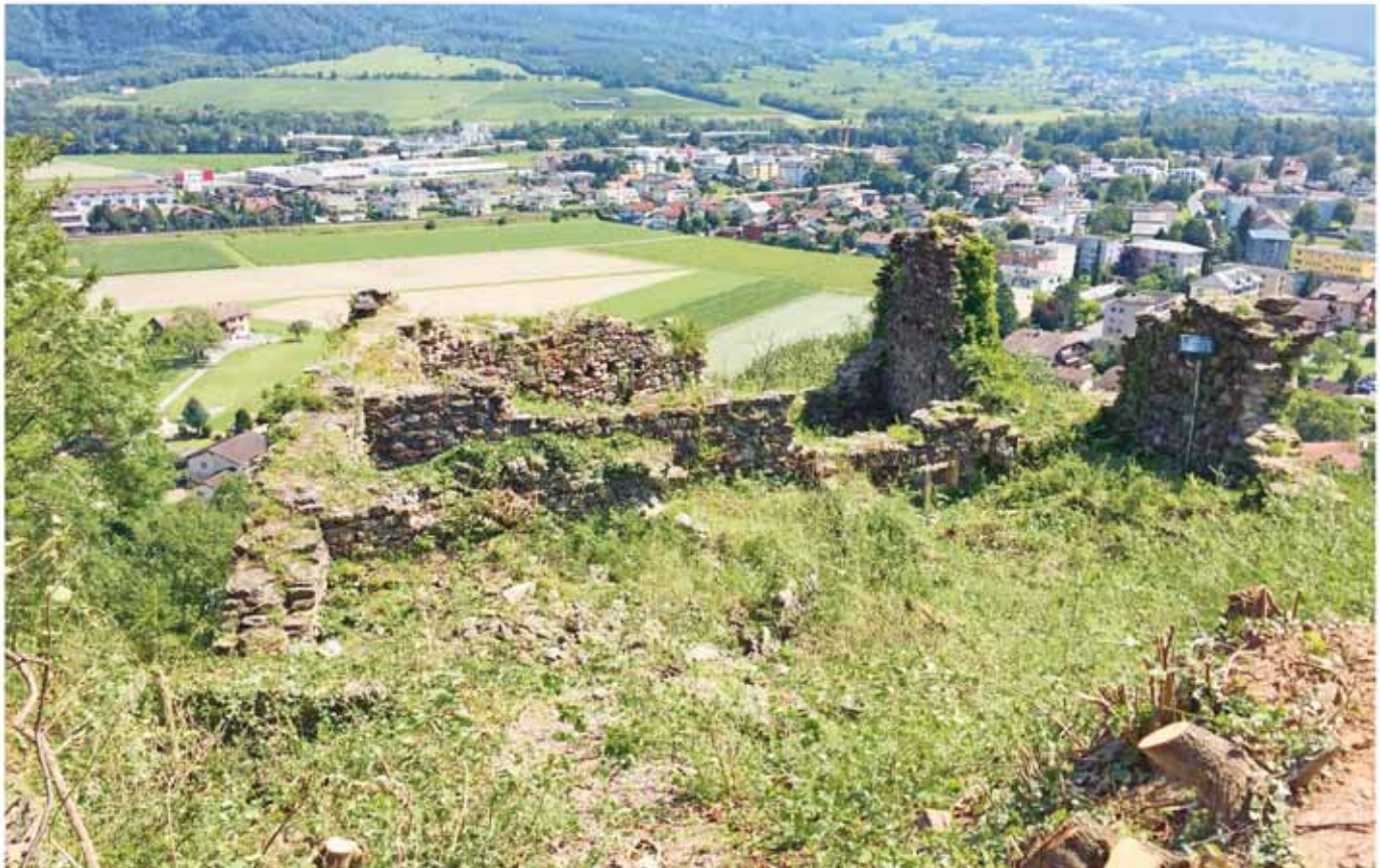
Ansicht vor Beginn der Sanierungsarbeiten
