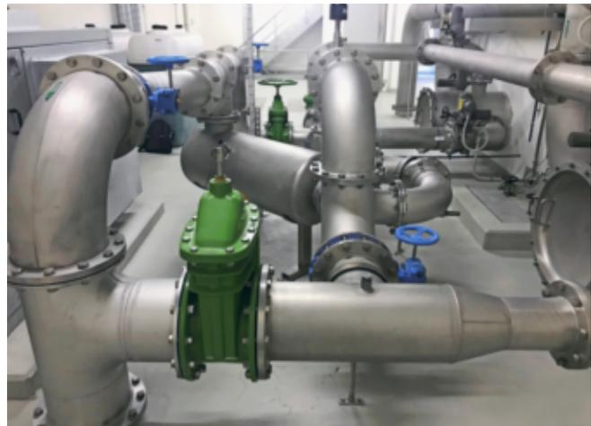
*Die installierte Bestrahlungskammer mit UV-Amalgamstrahlern (Bildmitte) sorgt für keimfreies Trinkwasser in der Wasserversorgung.*
