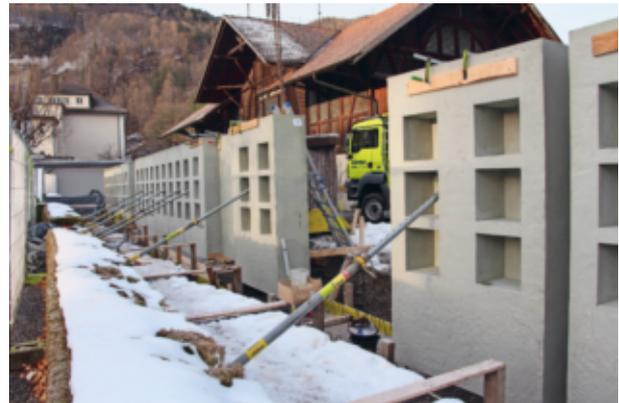
*Ausrichtung und Setzung der vorgefertigten Urnenwandelemente*
