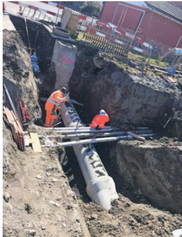
Der Meteorkanal ist an den Kontrollschacht angeschlossen und wird wieder eingedeckt.
