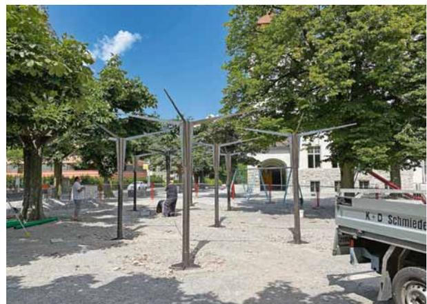
*Montage der Stahlstützen auf Fundamente zwischen dem unter kommunalem Schutzstatus stehenden Kastanienbaumbestand*
