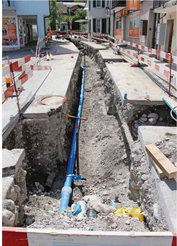
*Die neue duktile Gussleitung in der Hintergasse ist verlegt. Die weiteren Werkleitungen für Erdgas und Kabelfernsehen werden im Stufengraben weitergeführt.*
