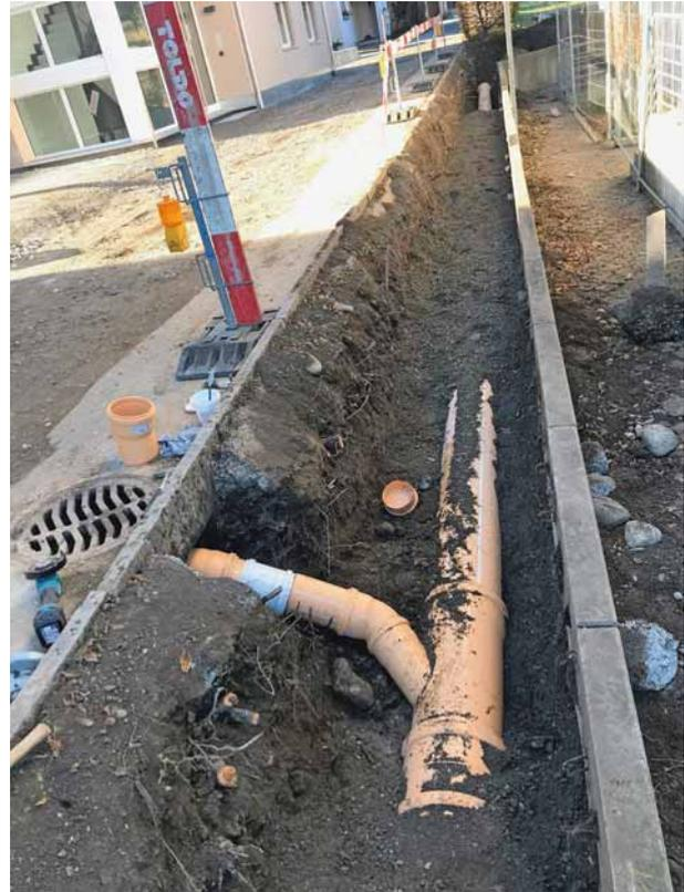
Der bestehende Strassenentwässerungsschacht beim Fallersweg wird an die neue Meteorleitung angeschlossen.
