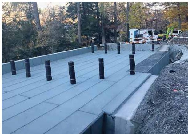
*Die Reservoirdecke und die Aussenwände wurden zusätzlich bewehrt und mit einem Konstruktionsbeton verstärkt. Es folgte eine Abdichtung mit Schutzmatte und Misaporschüttung, darüber ein Vlies und die Auffüllung mit dem seitlich gelagerten Aushubmaterial.*
