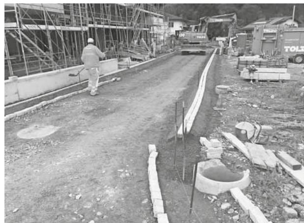
*Die Randabschlüsse der Buchenstrasse werden erstellt, bevor die Tragschicht eingebaut werden kann.*
