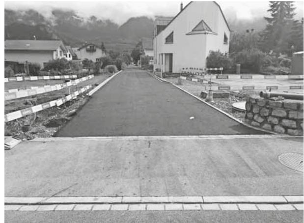
*Die Tragschicht bei der Calandastrasse ist eingebaut. Randabschlüsse, Mauern und Einfriedungen beim linksseitigen Einlenker zur Sarganserstrasse wurden bis Schulbeginn im August erstellt.*
