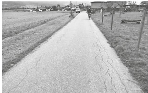
*Die Scadonsstrasse mit Blick Richtung St. Leonhard vor der Sanierung. Die Spuren der hohen Belastung sind deutlich zu erkennen – die Erneuerung der Oberschicht deshalb begründet.*
