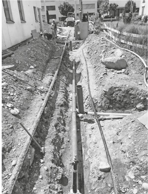
*Die neue duktile Gussleitung in der Calandastrasse ist teilweise bereits eingedeckt, die Schieber und eine Hausanschlussleitung sind noch erkennbar.*
