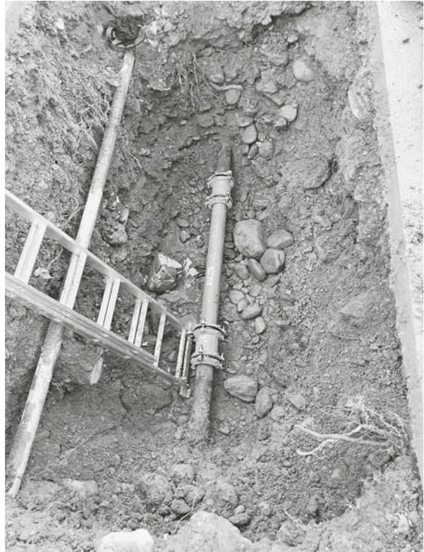
*Für die Reparatur der defekten Hydrantenleitung GG Ø 100/116 in der Taminastrasse musste das Wasser kurzfristig für rund sieben Stunden abgestellt werden.*
