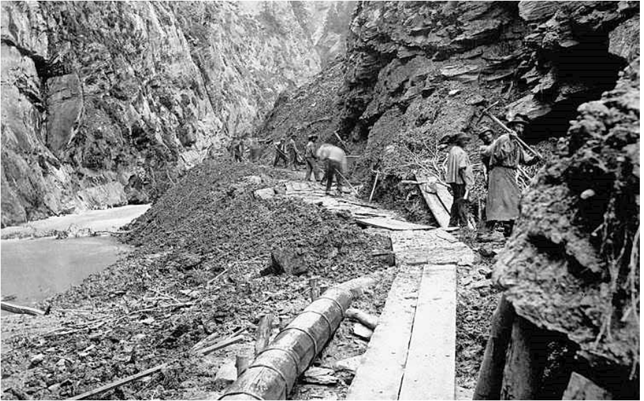
Bau der Teuchelleitung vom Bad Pfäfers zum «Hof Ragaz»
