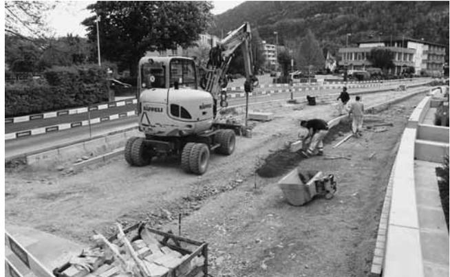
*Die Randsteine für das Trottoir und die Mittelinsel bei der Bahnhofstrasse werden verteilt und eingebaut.*
