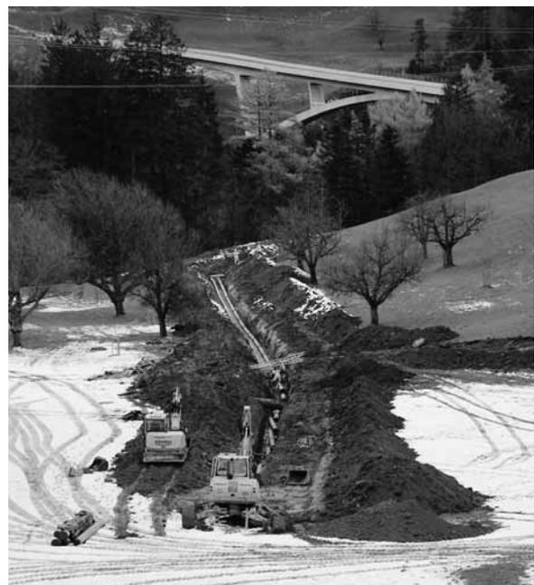
Die neu erstellte Druckleitung DN 250 im Gebiet Bofel Pfäfers mit Blick Richtung Taminabrücke.
