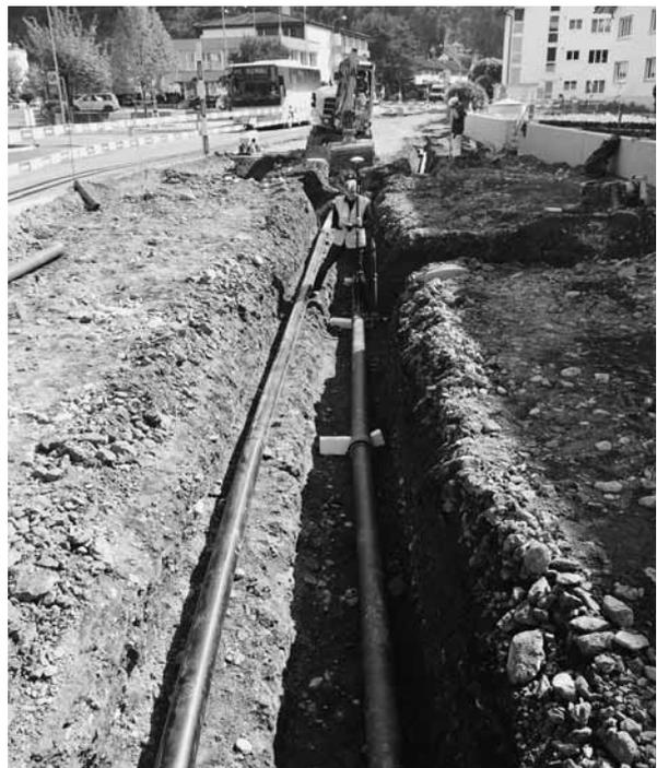
*Die neue duktile Gussleitung (rechts) in der Bahnhofstrasse wird im Graben vor der Eindeckung eingemessen.*
