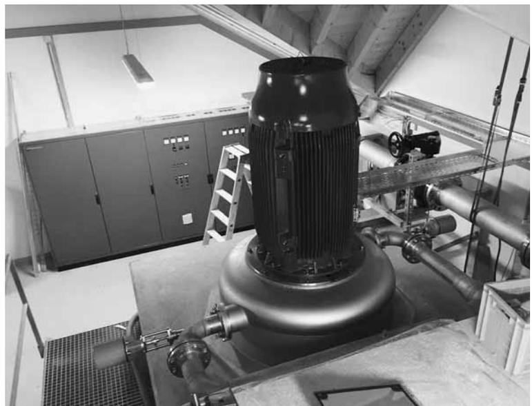
*Reservoir St. Niklausen, im Obergeschoss die vertikale Turbine mit Asynchrongenerator, Elektro-Schaltschrank und Verrohrung.*
