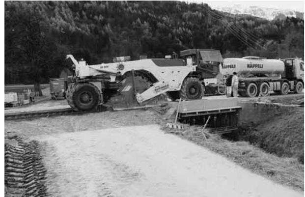
*Die Fräsmaschine hat die sanierte Betonbrücke über den Saschielbach erreicht und muss wieder neu ansetzen.*
