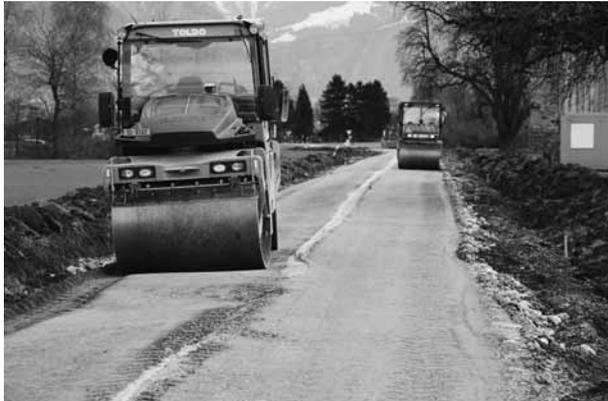
*Das mit Zement und Wasser vermischte Fräsgut aus Teerbelag, Planie- und Unterbaumaterial wird mit Walzen verdichtet und stabilisiert.*
