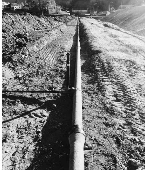
*Die neue Wasserleitung im Dammweg wird verlegt und die Baulandparzelle mit einer Hausanschlussleitung erschlossen.*
