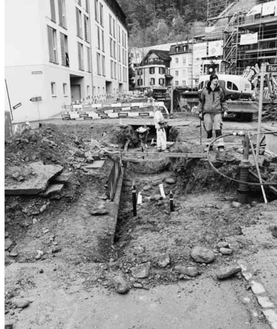
*Der Werkleitungsgraben wird an der Hintergasse verfüllt und verdichtet – Blick Richtung Valenserstrasse.*
