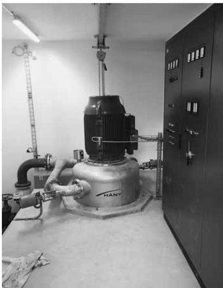
*Technikgebäude Final mit vertikaler Turbine und Asynchrongenerator, Elektro-Schaltschrank und Verrohrung.*
