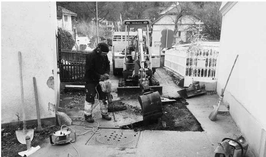
*Für die Reparatur der defekten Wasserleitung GG Ø 100/116 wird an der Mühlerainstrasse die Strasse aufgebrochen.*
