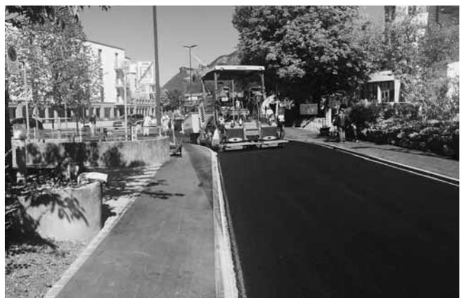
*Ende September konnte an der Kirchgasse der Deckbelag auf der Fahrbahn eingebaut werden.*
