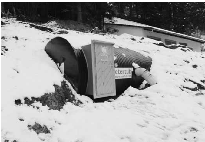
Das Ausgleichsreservoir Vaschnäris am Hangfuss eingebettet, im Hintergrund das alte Munitionsdepot an der Vättnerstrasse.
