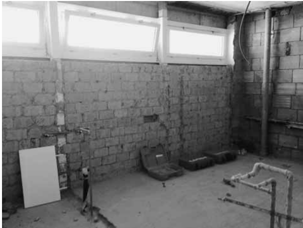
Ehemaliger Sanitärraum nach Schadstoffsanierung
