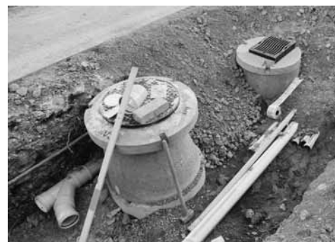
An der oberen Bidemsstrasse ist der Graben für die Weiterführung der neuen Werkleitungen bereit.
