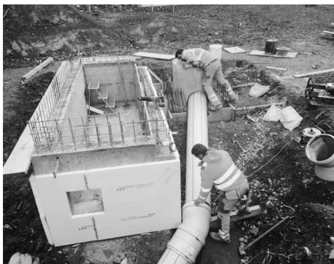
Die Foundation des Technikgebäudes Final ist erstellt, die Ableitungen des Wassers in den Niklausenbach werden verlegt.
