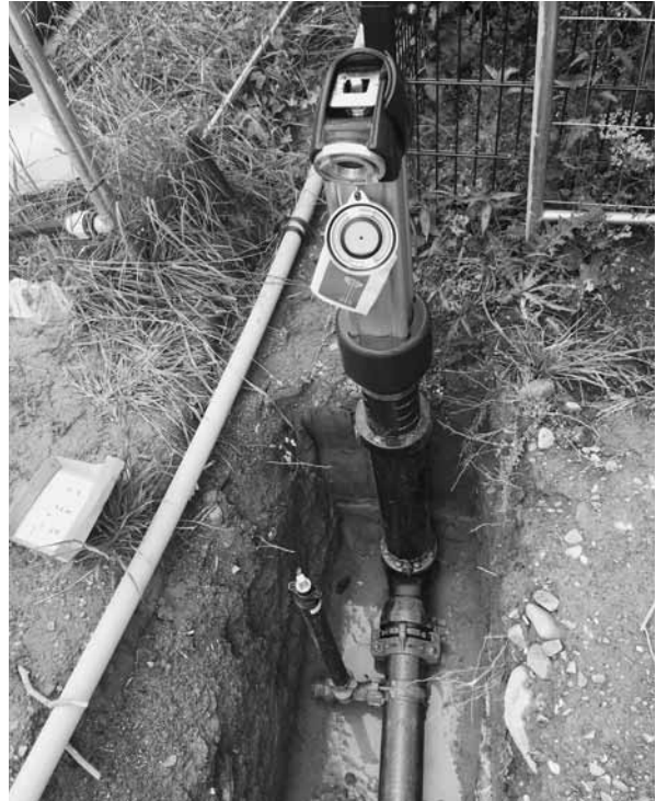
Der neue Hydrant beim Wendehammer am Mattenweg wurde gesetzt.
