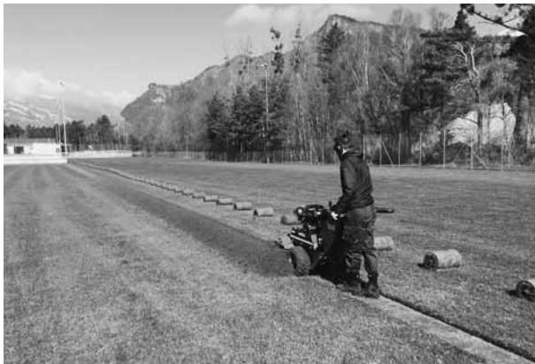
Nach dem Abschälen des Rasens zieht die Fräse einen 60 cm tiefen Graben für die Leitungen.
