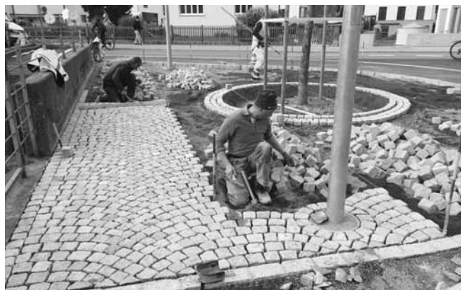
Die Freifläche im Verzweigungsbereich Kirchgasse – Bahnhofstrasse wird mit einer Bogenpflasterung aus Granitsteinen und dem Setzen einer Kaiserlinde augenfällig aufgewertet.
