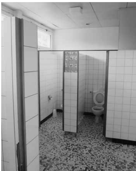
Sanitärraum vor Sanierung
