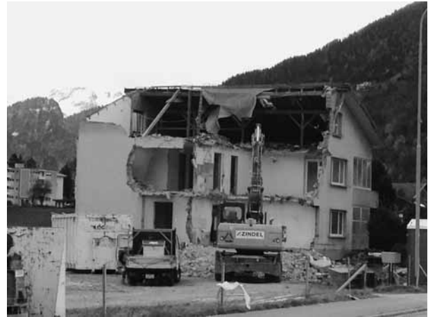
Rückbau Wohnhaus Kühne-Dosch
