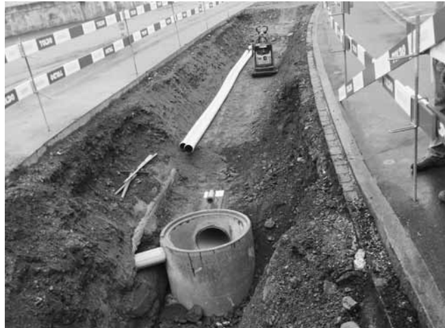
Der Graben für die neue Regenwasserableitung in der Bahnhofstrasse, im Bereich Rampe, ist verlegebereit.
