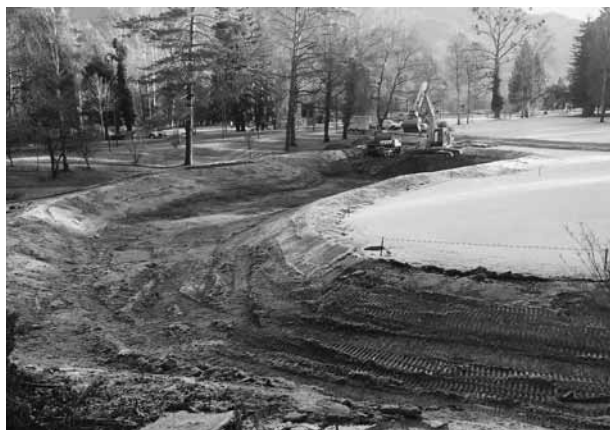
Das neue Retentionsbecken des Niklausenbachs auf dem Areal des Golfplatzes wird gestaltet.
