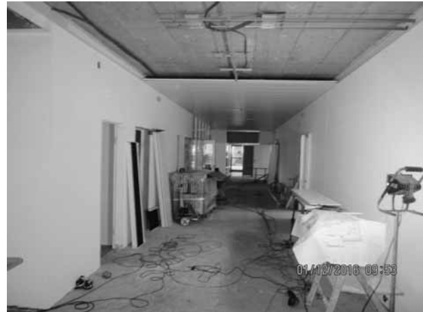
Montage Akustikdecke im Korridor
