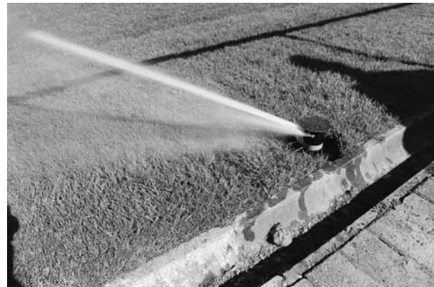
Ein Regner auf dem Sportplatz Ri-Au mit einer Reichweite von ca. 28 m in Betrieb.
