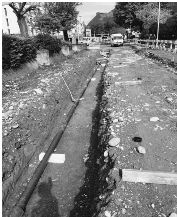
Die duktile Gussleitung im Graben verlegt an der Kirchgasse mit Blick Richtung Bahnhof.
