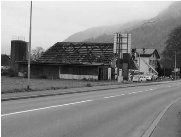
Schadstoffsanierung Eternitdacheindeckung Stallgebäude
