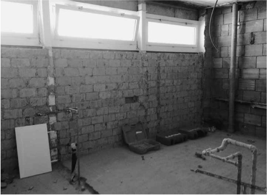
*WC-Raum nach erfolgter Asbestschadstoffsanierung (August 2016)*
