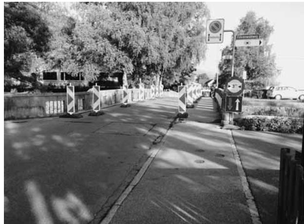
*Blickrichtung Fläscherstrasse: Sandbrücke mit eingengter Fahrbahn zur Entlastung der Aussenträger.*
