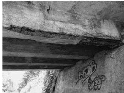
Unterbau der Sandbrücke mit Betonrissen.
