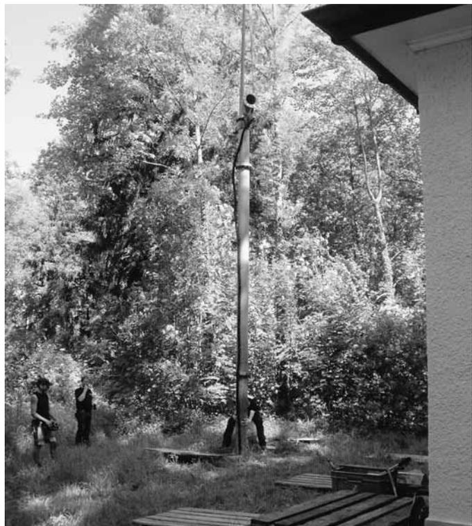
*Die defekte Unterwassermotorpumpe mit Rohranlage und Stromkabel wurde mit einem Kran aus dem 22 m tiefen Grundwasserschacht gezogen.*
