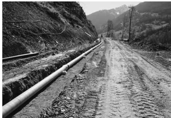
Die neu erstellte Druckleitung DN 250 ab Valur in Blickrichtung Brücke Bofel.
