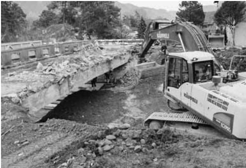
Die im Jahr 1917 aus Ortbeton erstellte Plattenbalkenbrücke wird zurückgebaut.
