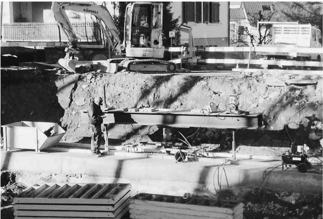
Bei einem Mikropfahl wird eine Belastungsprobe mit einer hydraulischen Presse durchgeführt. Die Messergebnisse sind sehr gut, dies dank kompaktem Taminaschotter.
