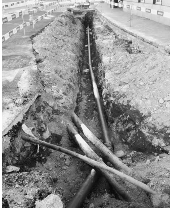
Die neue Anschlussleitung in der Pfäferserstrasse ab der Sarganserstrasse mit Blick Richtung Dorfzentrum, kurz vor dem Zudecken.
