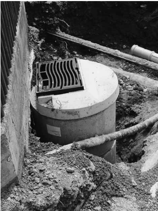
Bei der Einmündung in den Blumenweg wird ein neuer Einlaufschacht für die Strassenentwässerung erstellt.
