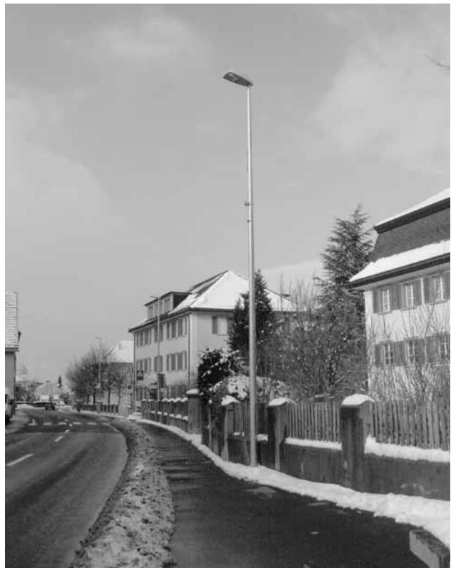
Die neue Strassenbeleuchtung entlang der Sarganserstrasse mit Anschluss für die Weihnachtsbeleuchtung.
