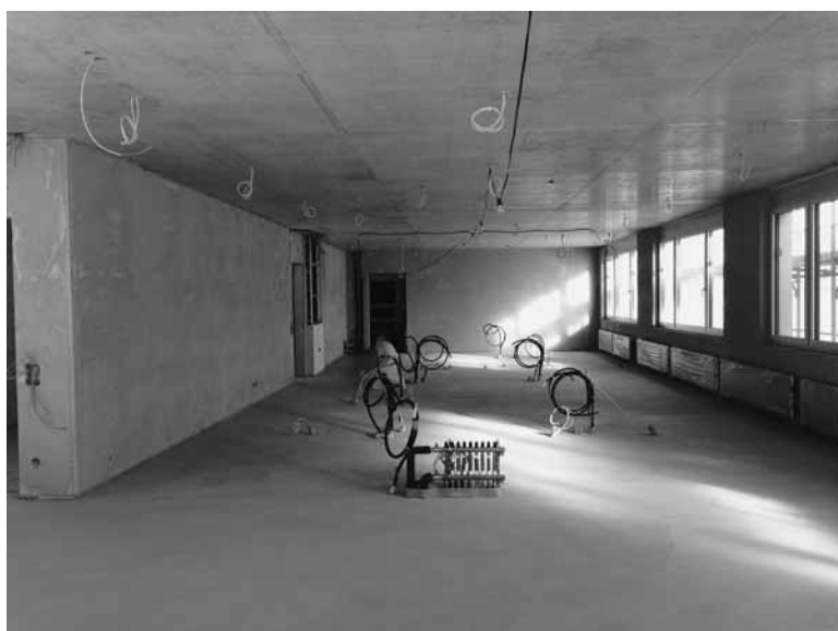
Unterlagsboden / Erschliessungsleitungen Küche
