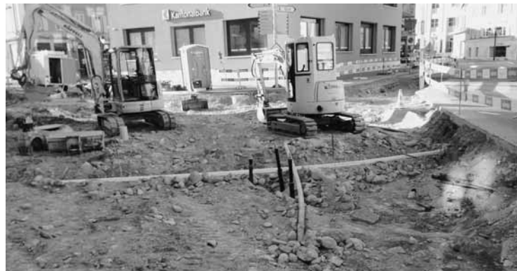
Mit der Sperrung der Kantonsstrasse im Bereich Kantonalbank/National Pub konnten die Tief- und Strassenbauarbeiten speditiv vorangetrieben werden.
