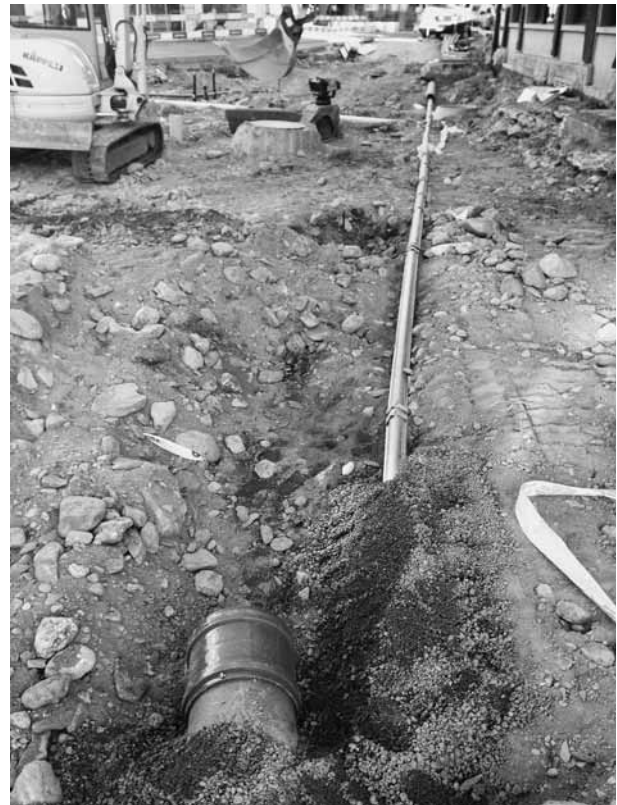
Der neue Meteorwasserkanal reicht nun bis zur katholischen Kirche und leitet das Strassenwasser über die Maienfelderstrasse bis in die Tamina.
