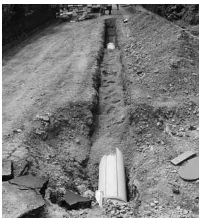
Die neue Meteorkanalisation in der Fläscherstrasse wird verlegt und eingedeckt.
