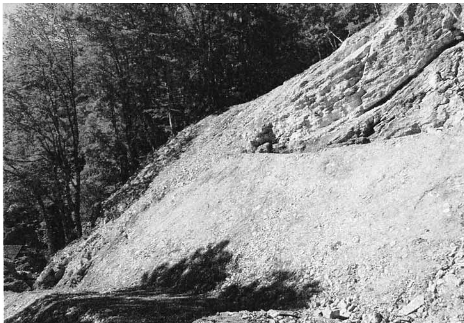
Felskopf nach Abtrag. Blick nach Süden. Es entstand eine regelmässig geneigte Böschung.
