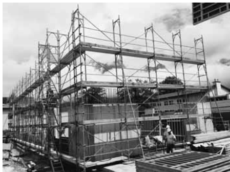
Vorbereitung Gerüste für 1. Obergeschoss
