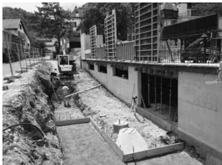
Vorbereitungsarbeiten für die Stützmauern Velorampe
