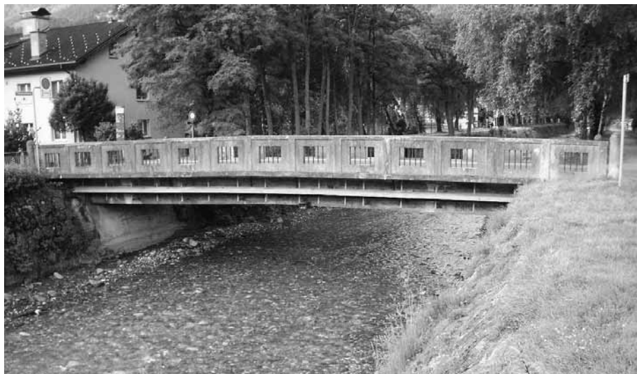
Der Baubeginn für die neue Sandbrücke ist auf Ende Oktober 2014 vorgesehen.
