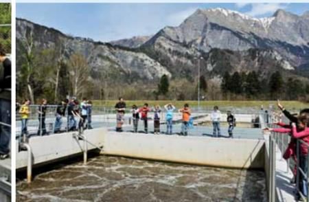
Der biologische Reinigungsprozess findet im Wirbelbett statt. Dabei «ernähren» sich Mikroorganismen – vor allem Bakterien – teils schwimmend im Wasser, teils festsetzend auf Füllkörpern von den Schmutzstoffen und bauen diese so ab. Damit die Mikroorganismen das Abwasser optimal reinigen, wird mit Gebläsen Luft (Sauerstoff) zugeführt.
