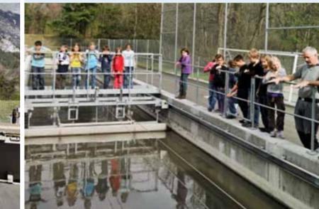
In den zwei Vorklärbecken hat das Abwasser eine niedrige Fließgeschwindigkeit, so dass sich weitere Feststoffe absetzen, die dann entfernt werden können. Die abgesetzten Feststoffe werden der Schlammbehandlung zugeführt (siehe Schlammbehandlung).
