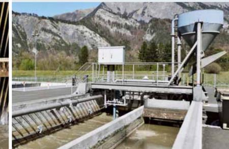
Im Sandfang werden gut absetzbare Stoffe wie Sand und Kies herausgenommen. Zusätzlich erfolgt die Entfernung von aufschwimmenden Fetten und Ölen.
