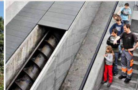
In der ARA wird das Abwasser mit Schneckenpumpen um mehr als 6 Meter in die Höhe befördert. Anschliessend fliesst das Wasser im freien Gefälle durch die ganze ARA und am Schluss gereinigt in den Rhein.
