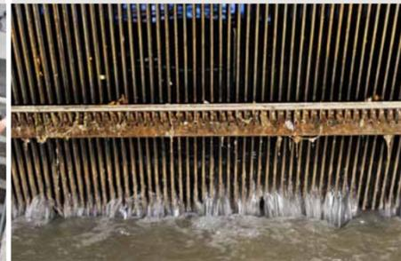
In der ersten Reinigungsstufe werden die grössten Verunreinigungen mit einem Rechen entfernt (Abstand der Stäbe: 1 cm).
