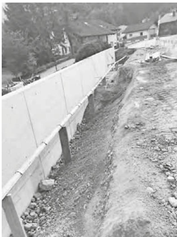
*Die Stützmauer ist erstellt und kann wieder hinterfüllt werden.*
