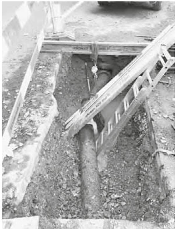
*Für die Reparatur der defekten Transportleitung GD Ø 250 musste das Wasser bei den Quellen in Vättis abgestellt werden.*
