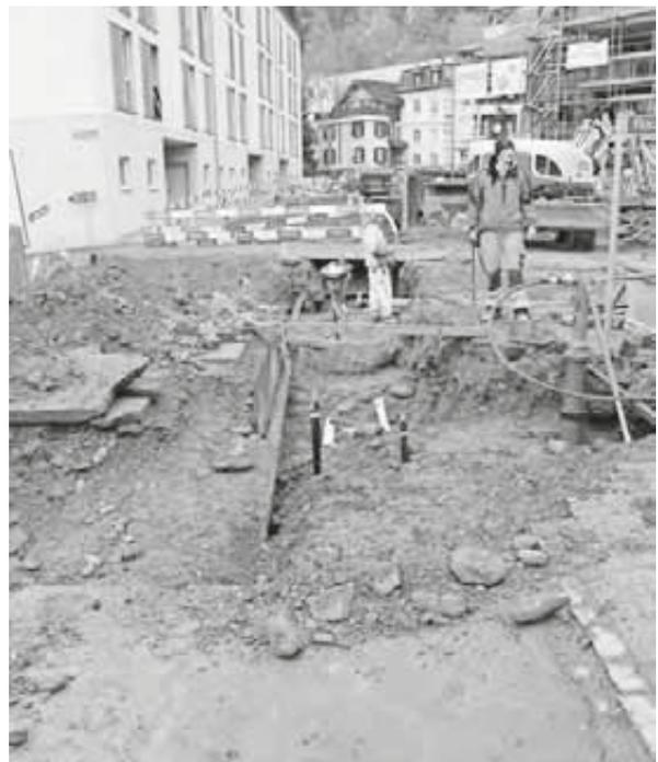
*Die neue duktile Gussleitung in der Hintergasse ist bereits eingedeckt, die Schieber und das Hydranten-Unterteil sind noch erkennbar.*
