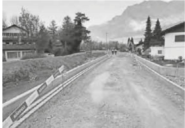
*Die Randabschlüsse, Stützmauern und temporären Wasserbaumassnahmen sind erstellt. Vor dem Einbau der Tragschicht wird die Fahrbahnplanie erstellt.*
