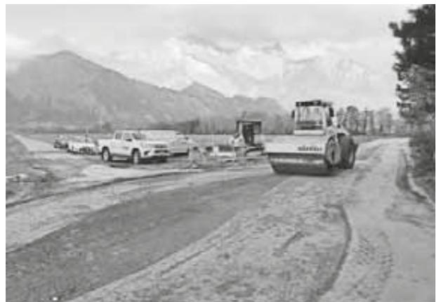
*Das mit Zement und Wasser vermischte Fräsgut aus Teerbelag, Planie- und Unterbaumaterial wird mit Walzen verdichtet und stabilisiert.*
