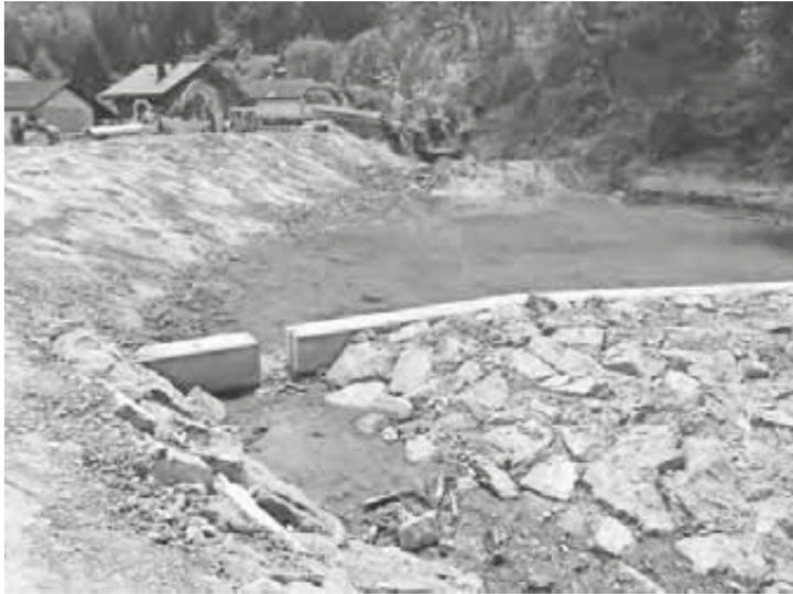
*Das neue Auslaufbauwerk beim Kiesfang Fluppe ist im Rohbau erstellt.*
