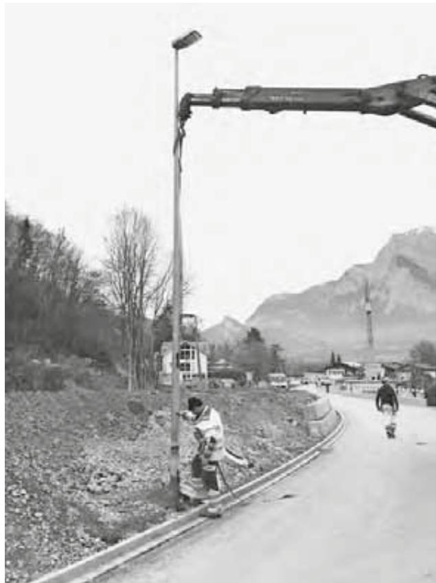
*Eine provisorisch gestellte Strassenlampe wird an der Fluppestrasse durch eine neue LED-Strassenlampe ersetzt.*
