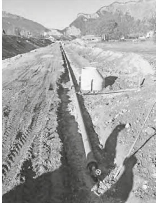
*Die duktile Gussleitung Ø 125/144 im Dammweg ist verlegt und die Druckprobe erfolgreich abgeschlossen. Die Hausanschlussschieber mit Erschliessungsleitung in PEHD 32.6/40 sind bis ins Grundstück verlegt.*
