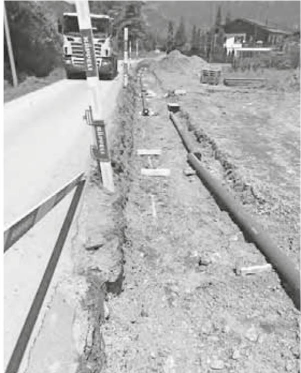
*Die neuen Rohre GD 150/170 der Wasserleitung in der Fluppestrasse werden verlegt.*
