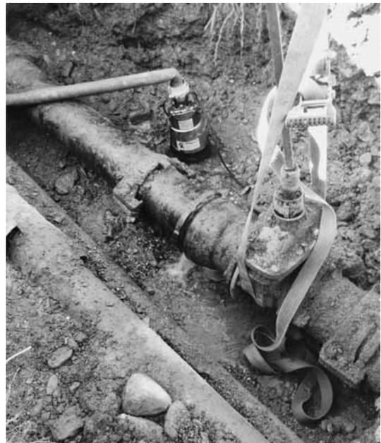
*Die undichte Wasserleitung GD 200 im Areal Casino / Thermalbad wird repariert.*
