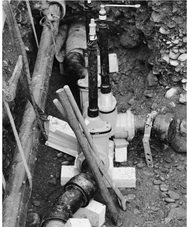
*Die neue Schieber-Kombination mit drei Absperrungen und Abgang mit Steckmuffen DN 150 in der Verzweigung Fläscherstrasse – Sandstrasse während der Installation.*
