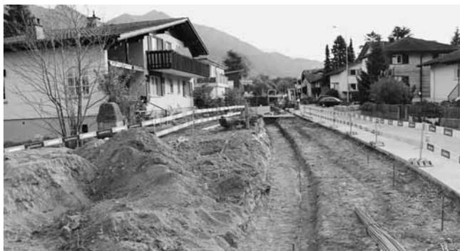
*Der Aushub für die neue Stützmauer und das Trottoir entlang der Unterrainstrasse ist für die Bauarbeiten bereit.*
