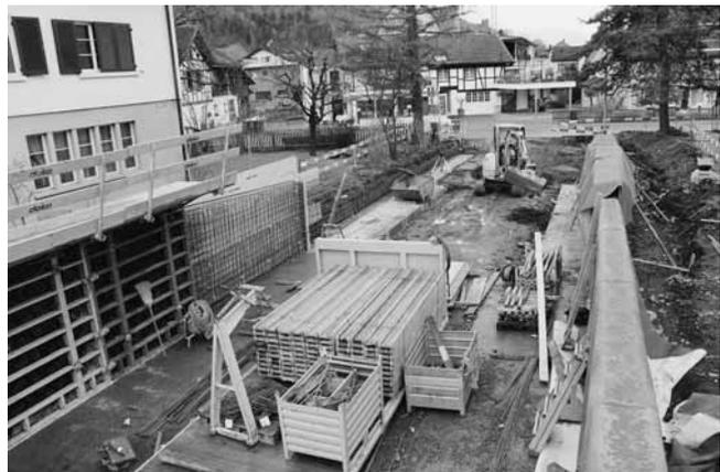
*Die Stützmauern bei der Rampenabfahrt zur Seite Fläscherstrasse werden erstellt.*
