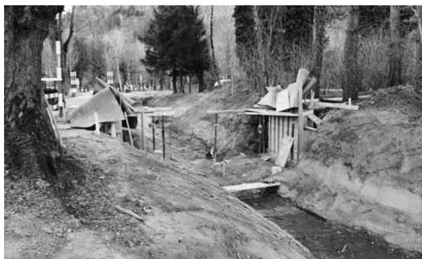
*Die Foundation für den neuen Fussgängersteg ist eingeschalt und betoniert.*
